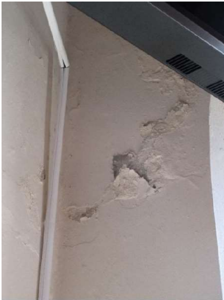
Nave SE corner
