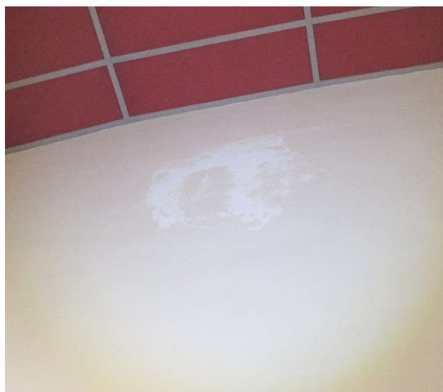
para 37 Nave W wall
