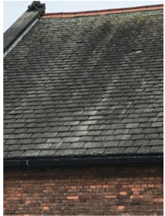
Uneven Ridge Tiles
