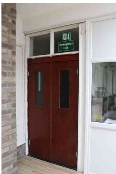
Hazardous dual swing fire door
