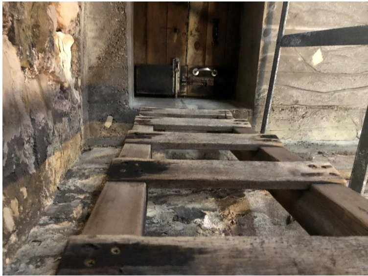
Fig 14. Tower access hatch/ladder
