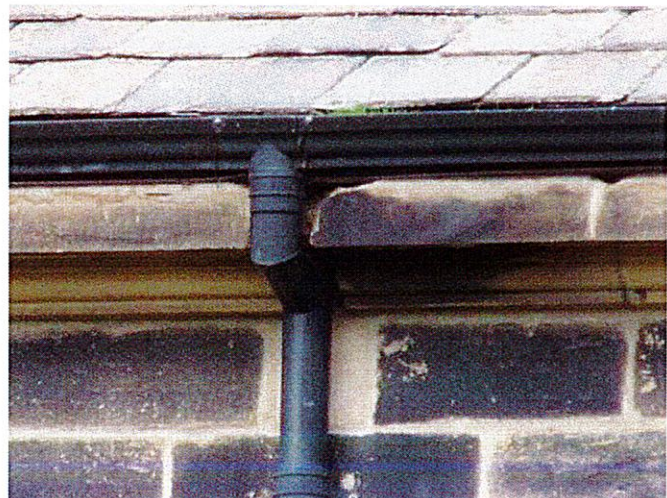
N gutter E outlet
