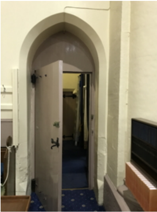
South Aisle/Porch Door
